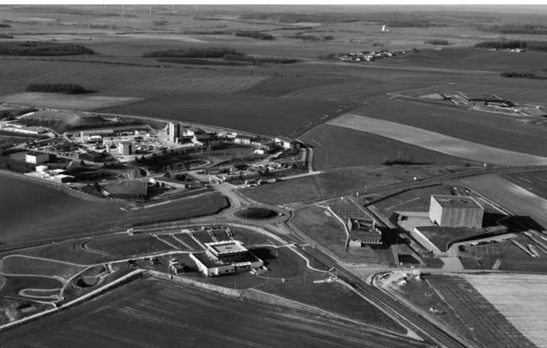
Le laboratoire de l’ANDRA construit dans les années 2000 à Bure
